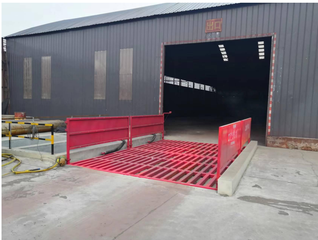
图 2-2 清洗平台施工后照片
